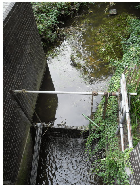
(d) Robinson pond sluice gate
